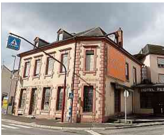
Von dem Hôtel de la Poste im Ortskern von Rosport bleiben die Außenmauern stehen.
